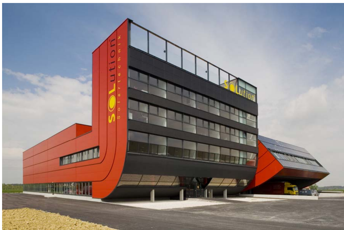
Foto: SOLution Solartechnik GmbH
