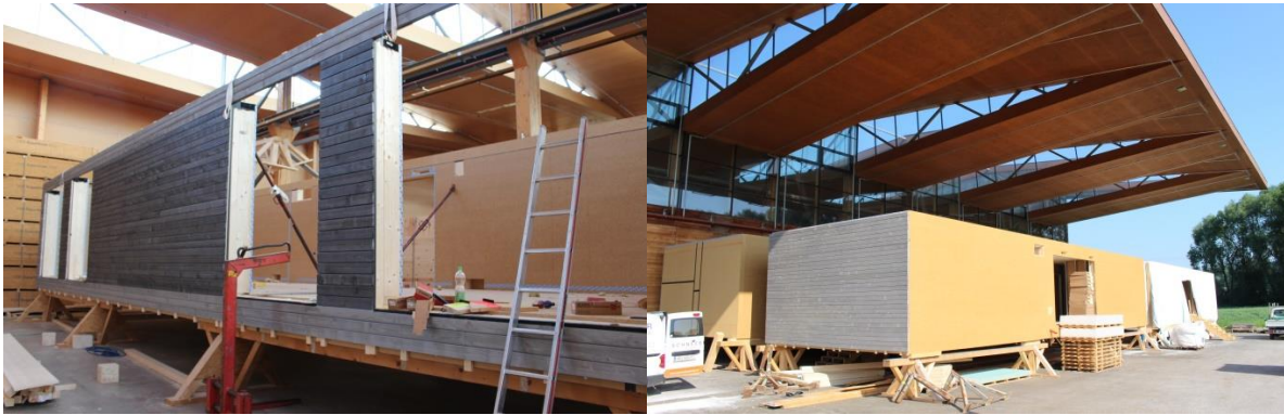
Picture 1+2 Prefabrication of GreenFlexStudioBoxes at Obermayr Holzkonstruktionen GmbH
