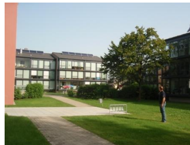
WHA 2009 nach Sanierung mit verglasten Loggien, Vollwärmeschutz, hocheffizienter Komfortlüftung und Solaranlage Quelle: IG Passivhaus Österreich
