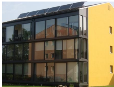
WHA 2009 nach Sanierung mit verglasten Loggien, Vollwärmeschutz, hocheffizienter Komfortlüftung und Solaranlage Quelle: IG Passivhaus Österreich
