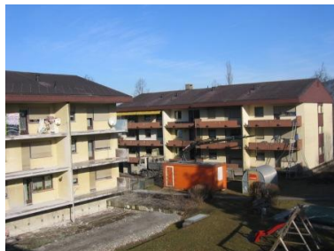
WHA Fussenau während Sanierung 2008 Quelle: VOGEWOSI
