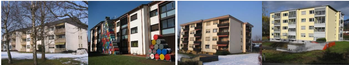
MFH Schleipfweg von 192 auf 16 kWh/m 2 a
