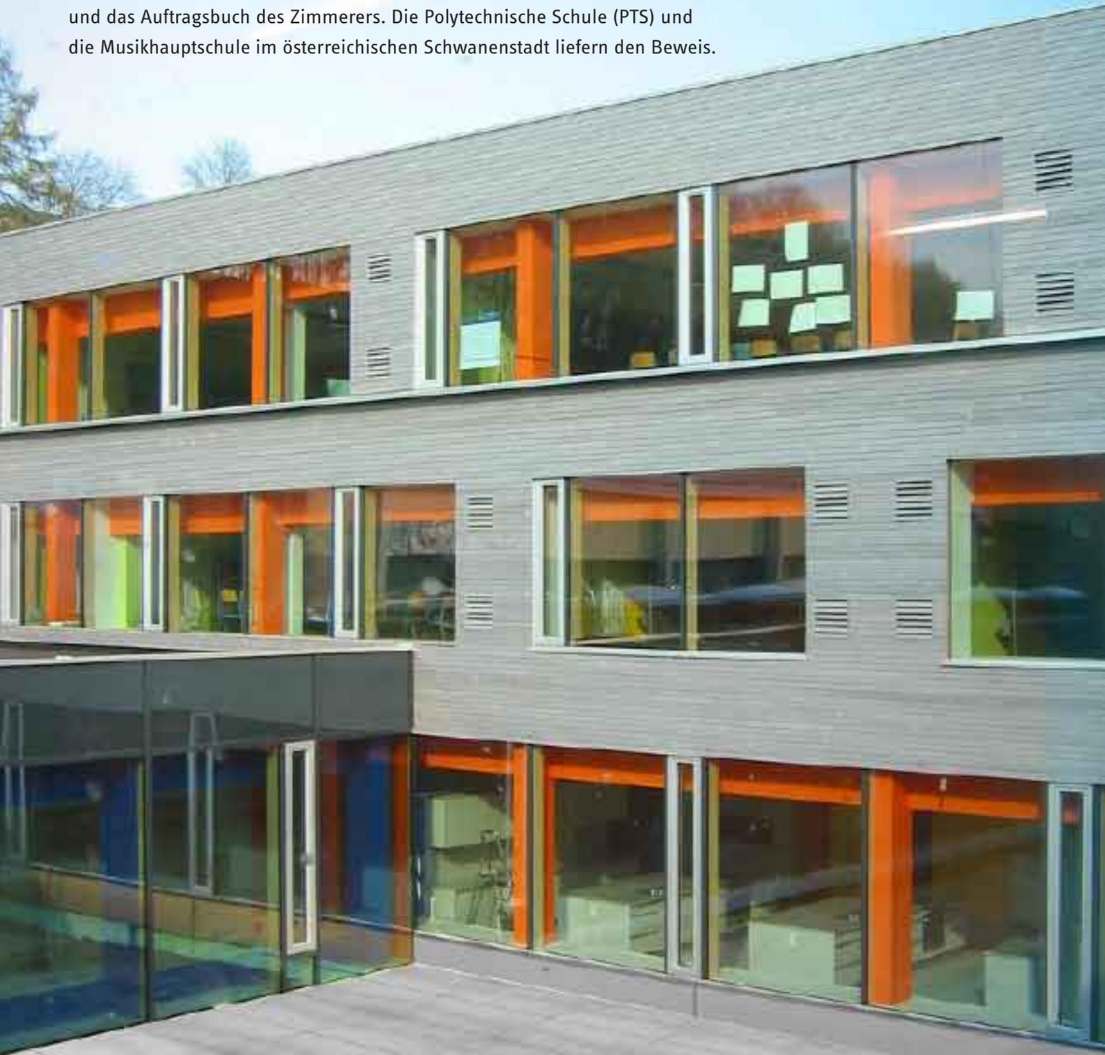
▲ Die neue Hülle im Passivhausstandard legt sich wie ein Mantel um den Stahlbetonskelettbau
