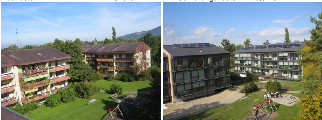
Abb. 6: Sanierung WHA Fussenau | links vor der Sanierung | rechts nach der Sanierung
