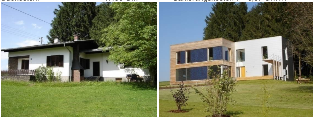
Abb. 8: Sanierung EFH Schwarz | links vor der Sanierung | rechts nach der Sanierung
