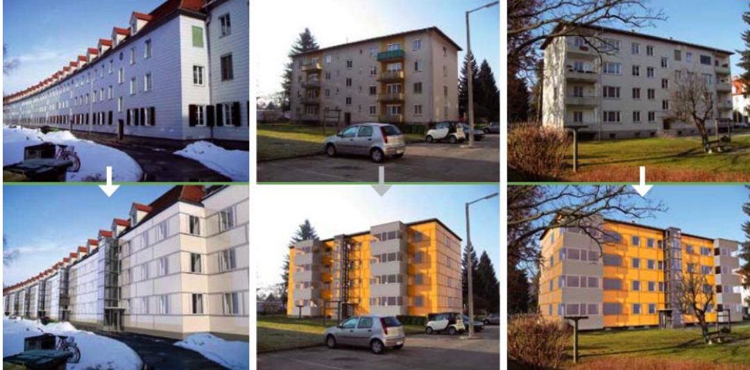
Abb. 7: Sanierung WHA Dieselweg | oben vor der Sanierung | unten nach der Sanierung
