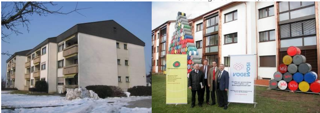
Abb. 5: Sanierung WHA Schleipweg | links vor der Sanierung | rechts nach der Sanierung
