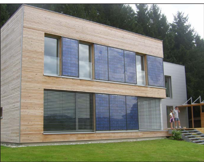
Eines von drei Beispielen: Dieses Einfamilienhaus in Pettenbach ist Baujahr 1960 – und heute erzeugt der sanierte Altbau seine Energie selbst. Dieses gelungene Beispiel einer Sanierung auf Passivhausstandard wurde dafür sogar mit dem OÖ. Holzbaupreis 2005 für besonders energieeffizientes Bauen ausgezeichnet. FOTO: IGPASSIVHAUS
