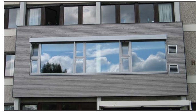
Die Haupt- und Polytechnische Schule in Schwanenstadt wird derzeit zum Passivhaus saniert. Im Bild die Musterklasse mit vorgehängter Holzfassade und Komfortlüftung. Spätestens in einem Jahr sollen auch alle anderen Klassen von der Passivhaus-Atmosphäre profitieren.
