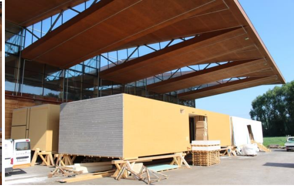
Bild 1+2) Vorfertigung der GreenFlexStudioBoxen bei der Firma Obermayr Holzkonstruktionen GmbH
