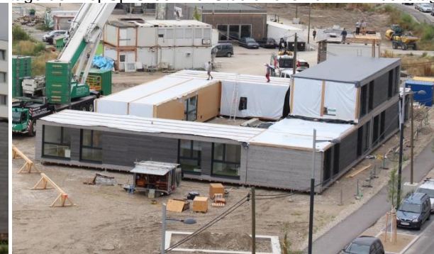
Bild 5+6) Bereits mit Anlieferung fertig eingerichtet. Montage der PopUp GreenFlexStudioBoxen am 2. Arbeitstag
