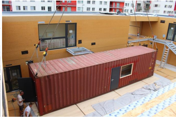
Bild 9+10) Montage des PopUp GreenFlexStudios und des Multifunktionscontainers am 6. Arbeitstag
