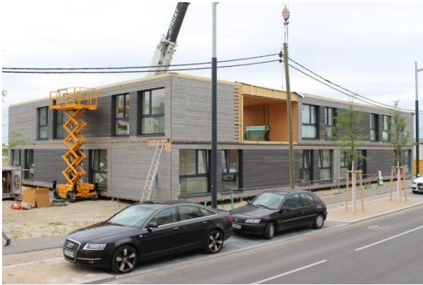
Bild 9+10) Montage des PopUp GreenFlexStudios und des Multifunktionscontainers am 6. Arbeitstag
