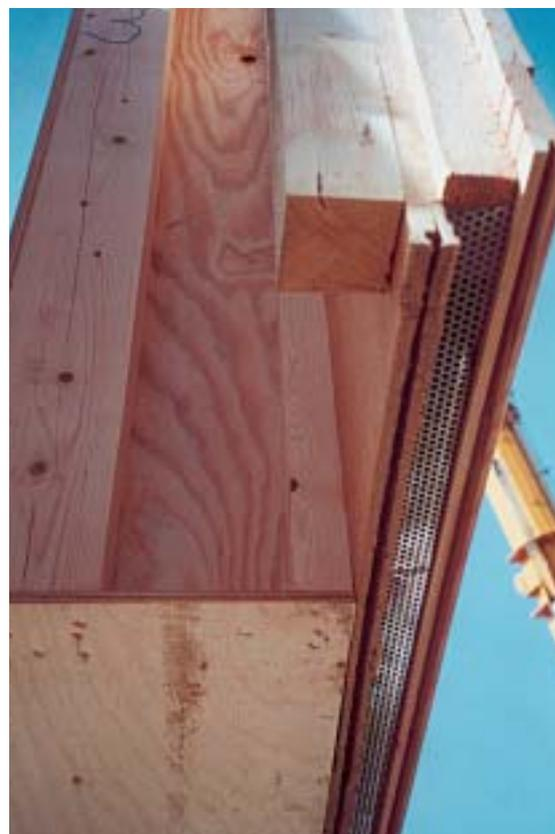
*Die besonders dichte Außenhaut lässt bei Passivhäusern so gut wie keine Energie mehr entweichen. Oben ein hochgedämmtes Außenwandelement während der Montage.*
