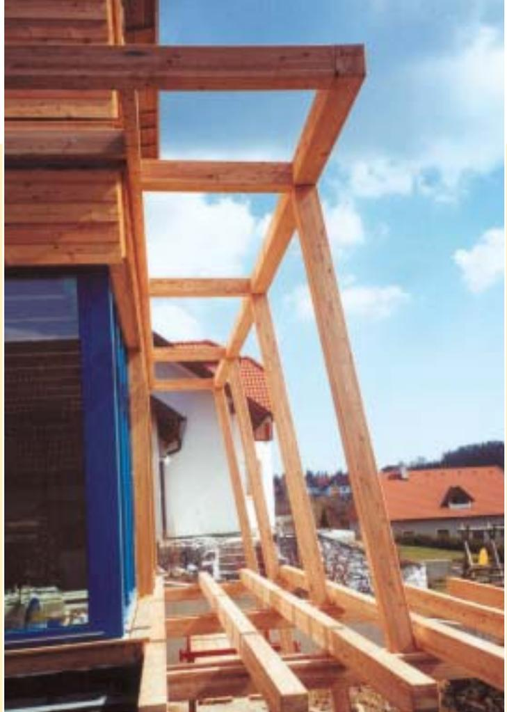
*Konstruktionsdetails: oben die Errichtung der Süd-Fassade, die durch großflächige Öffnung die Nutzung solarer Einträge erlaubt, links bzw. rechts das Versetzen der vorgefertigten Träger-Elemente, unten der Aufbau der Fußbodenkonstruktion.*
