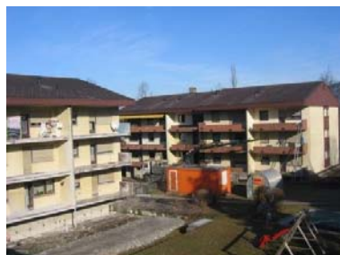
WHA Fussenau während Sanierung 2008 Quelle: VOGEWOSI
