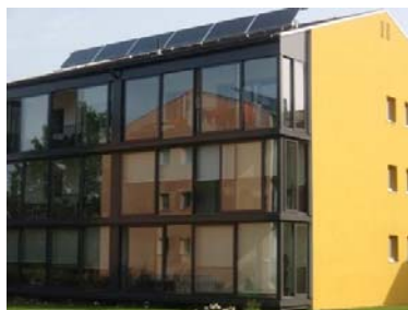
WHA 2009 nach Sanierung mit verglasten Loggien, Vollwärmeschutz, hocheffizienter Komfortlüftung und Solaranlage Quelle: IG Passivhaus Österreich
