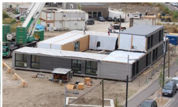
Bilder 8 + 9: Transport und Montage der fünfeinhalb Meter breiten vorgefertigten Wohnboxen durch die Firma Obermayr Holzkonstruktionen GmbH, Foto credits: LANG consulting
