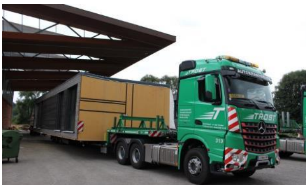
Bilder 8 + 9: Transport und Montage der fünfeinhalb Meter breiten vorgefertigten Wohnboxen durch die Firma Obermayr Holzkonstruktionen GmbH, Foto credits: LANG consulting
