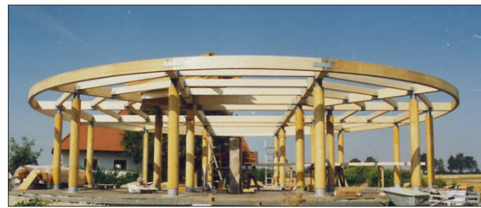
Beim Aufbau der Passivhaus Scheibe.
