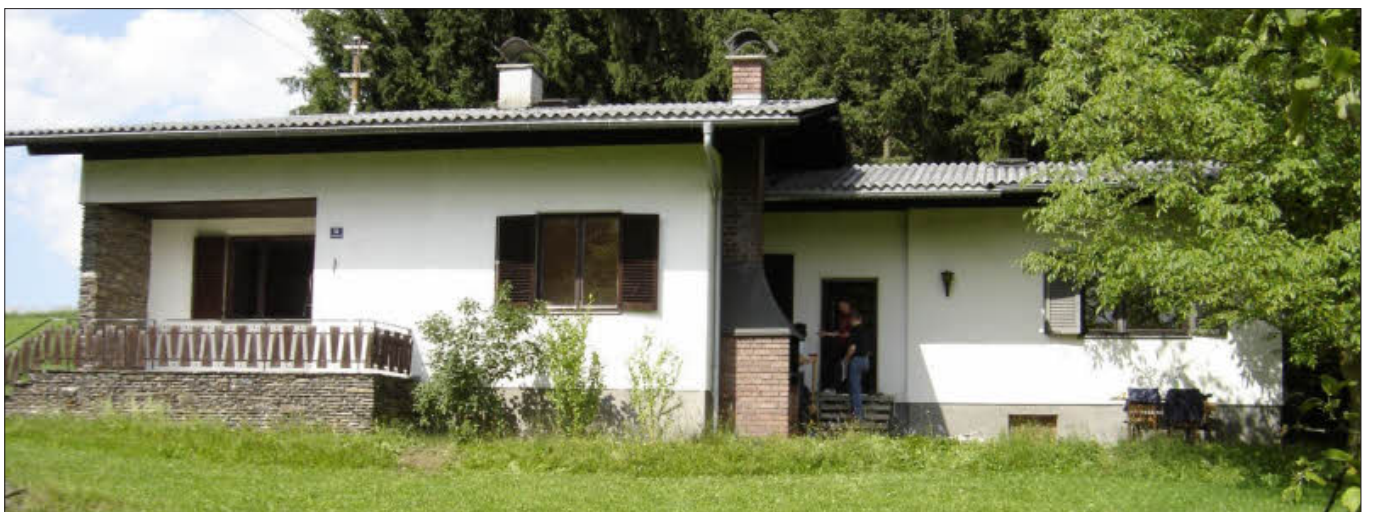
Kaum zu glauben: So hat das Einfamilienhaus vor der Sanierung ausgesehen – eines von tausenden typischen Häusern aus den 50er- bis 80er-Jahre.
