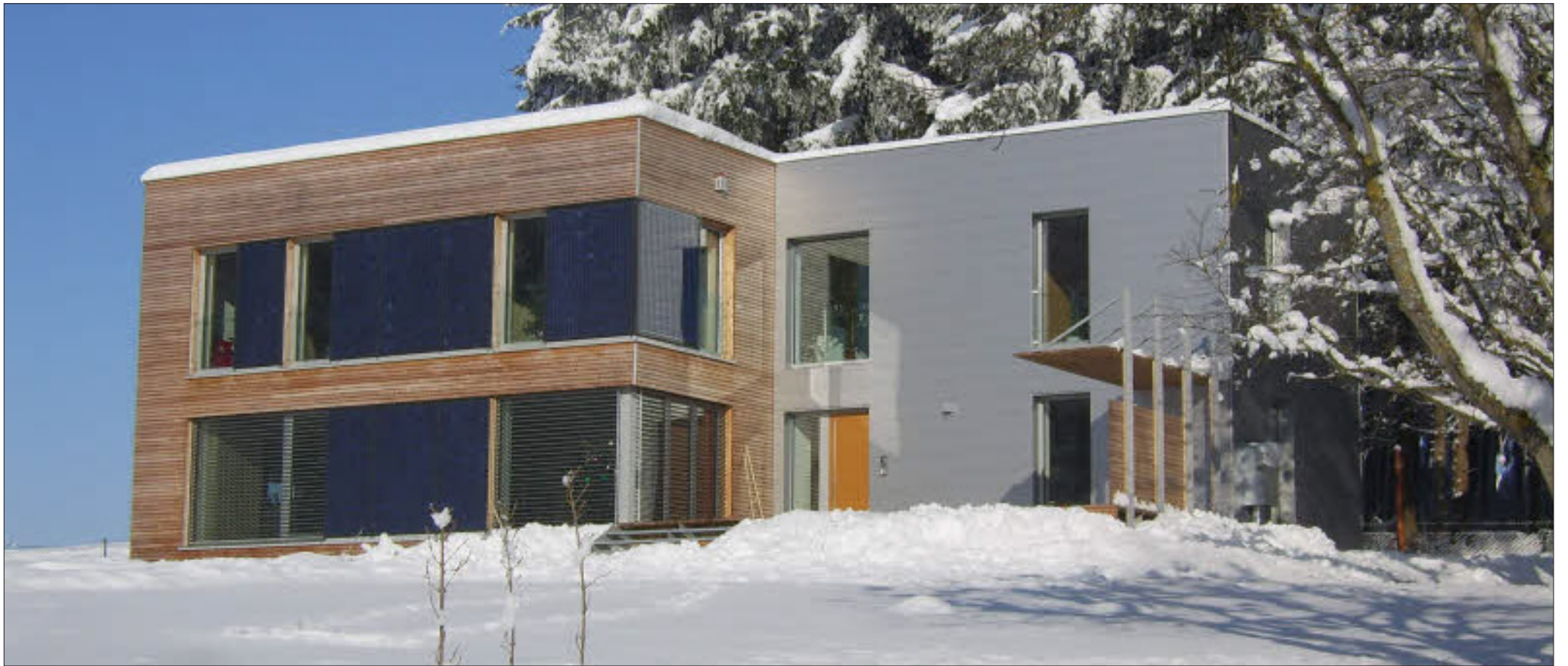
In Pettenbach (Oberösterreich) befindet sich Österreichs erstes Einfamilienhaus, das von einem Energiefresser zum Passivhaus saniert wurde. Dank moderner, vorgefertigter Holzbausysteme erstrahlte das alte Gebäude (Bild unten) nach nur drei Tagen Montagezeit in einem völlig neuen Kleid. Der minimale Restenergiebedarf für die Raumwärme des Passivhauses wird komplett von der in der elegant in der Holzfassade integrierten Photovoltaikanlage abgedeckt. Fazit: Wohnkomfort und Energieeinsparung sind kein Widerspruch – ganz im Gegenteil! Bilder: LANG CONSULTING/WWW.PASSIVHOUSE.AT
